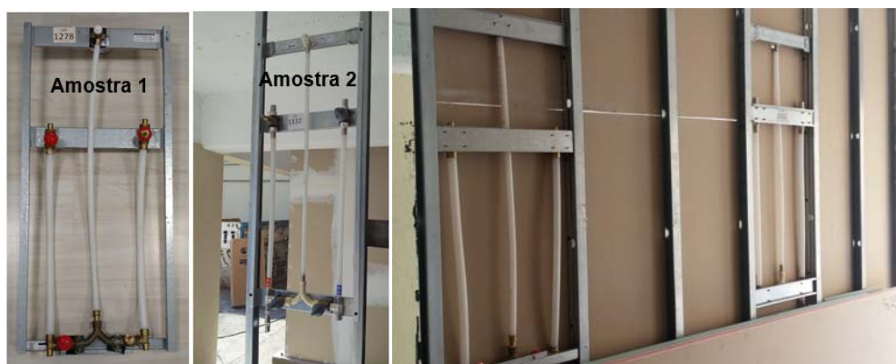
Figura 4 – Kits hidráulicos para chuveiro utilizados em sistemas drywall
