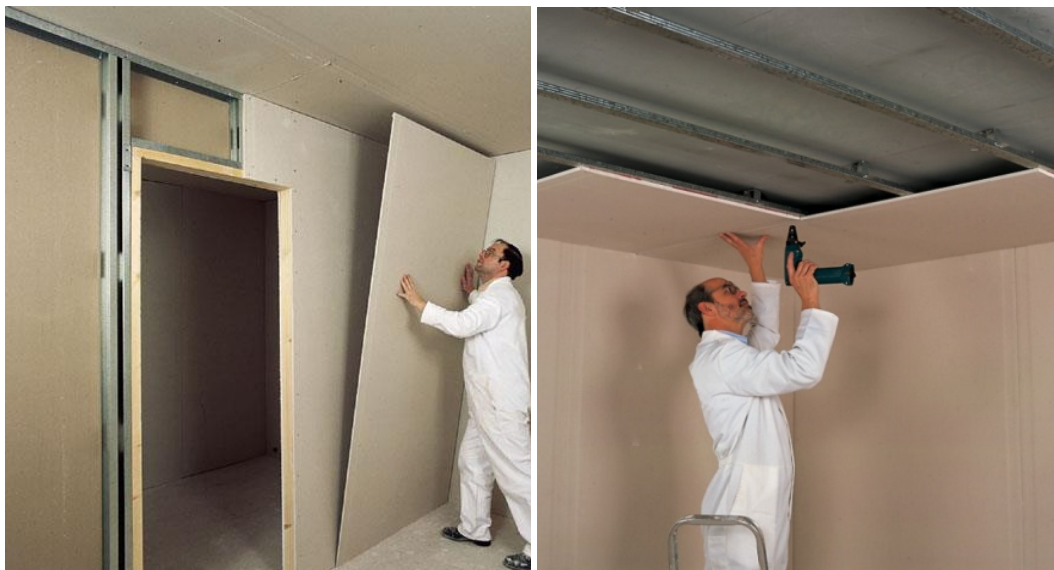
Figura 2 – Montagem do sistema construtivo em chapas de gesso para drywall
